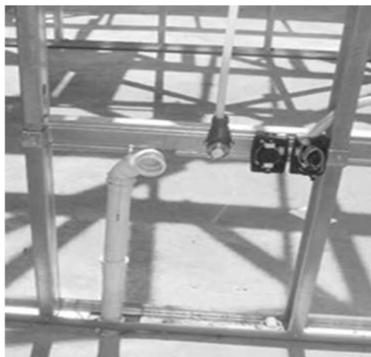
Figura 23 – Exemplo de instalação da infraestrutura.
