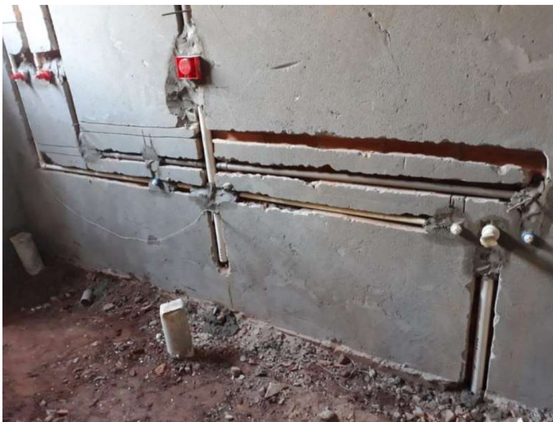
Figura 2 – Instalações de infraestrutura no método convencional.
