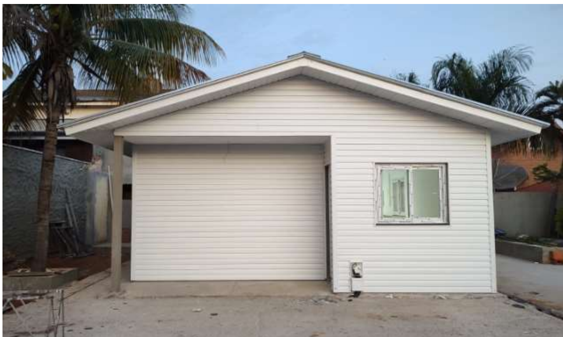
Figura 21 – Exemplo de vedação externa
