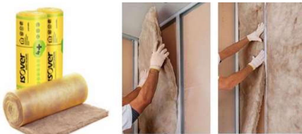
Figura 22 – Lã mineral aplicada entre os vãos das paredes LSF/ Drywall
