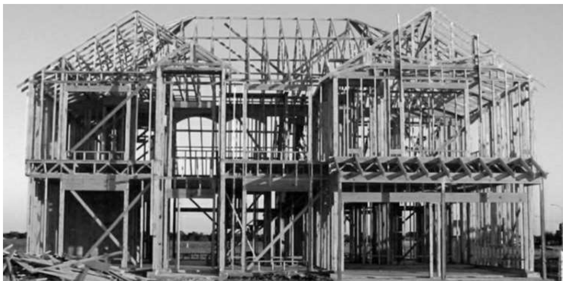
Figura 3 – Estrutura do sistema Light Steel Frame
