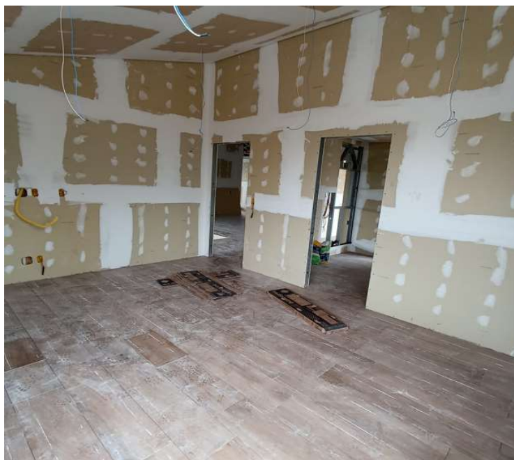
Figura 24 – Paredes e forro instalados com chapas de gesso acartonado.
